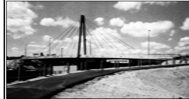
Most od polimera armiranog karbonskim vlaknima
