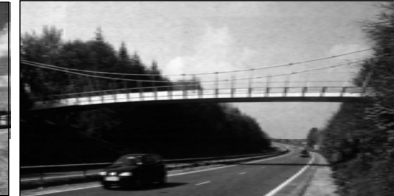
Most sa kolničkom konstrukcijom od polimera armiranog staklenim vlaknima
